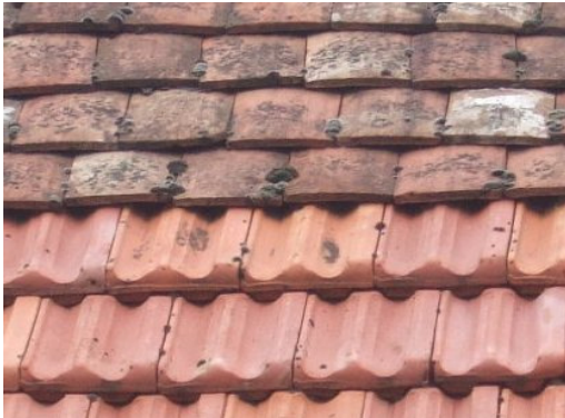
oben: Biberschwanz, unten: Doppelmuldenfalzziegel
