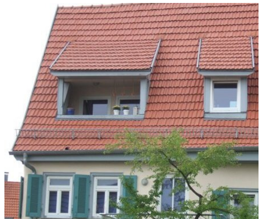
Beispielhaft: Unauffällig gestalteter Dacheinschnitt, Doppelmuldenfalzziegel
