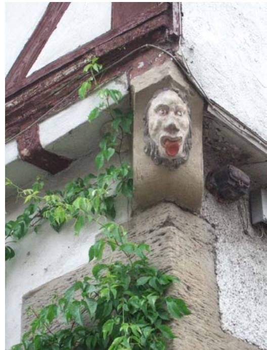
Detail Kleinheppacher Straße 7
