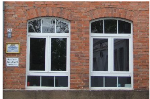
Beispielhaft wurden neue Fenster der alten Maueröffnung angepasst.
