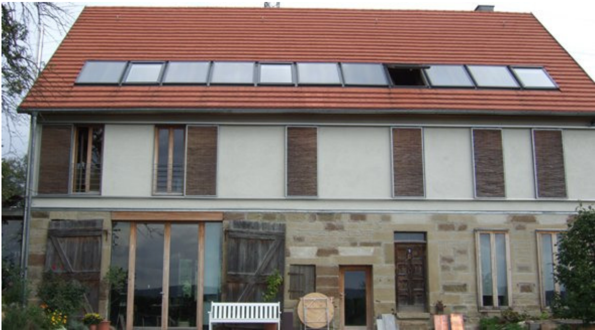
Beispielhaft: Indachsolaranlage im Wechsel mit Dachflächenfenster
