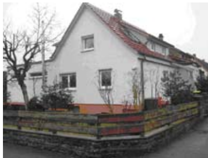
Das Haus nach der Sanierung im Dezember 2010
