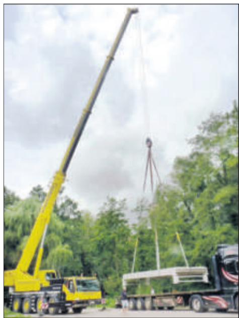
Vorsichtig hebt der bis auf 42 Meter Länge ausfahrbare Arm des Krans die zwei Tonnen schwere Brücke vom Tieflader herunter. Ein Klacks für den Kran, der bis zu 60 Tonnen heben kann.
