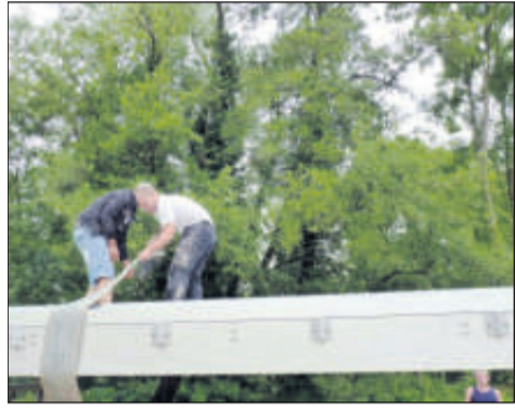
Die neue Alu-Brücke wird an Gurten befestigt.
