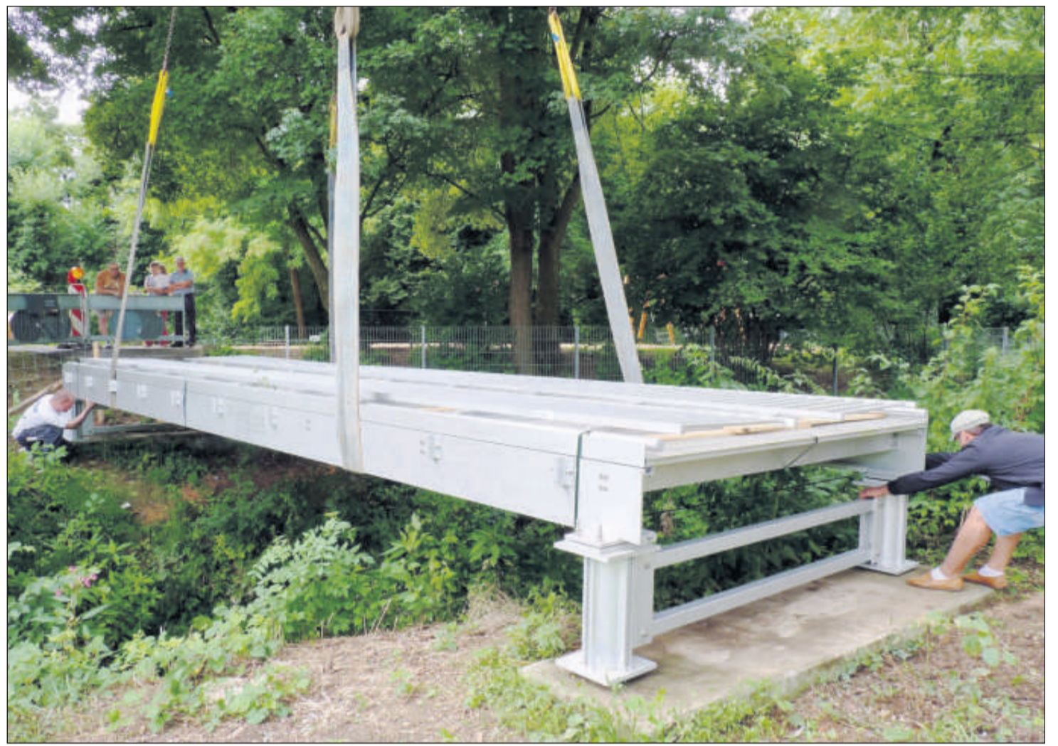
Feinarbeit ist das letzte Justieren der Aluminium-Brücke über den Kätzenbach, der die Brühlwiese und den Schiffsspielplatz voneinander trennt. Georg Hinze (links) und Serkan Ak platzieren den neuen Steg auf den Fundamenten des vorherigen Holzbrückleins. Fotos: David
