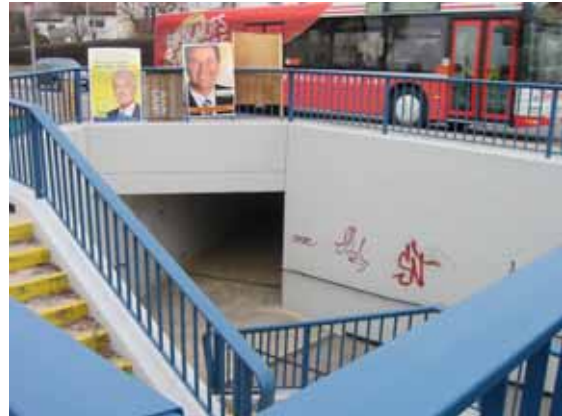
Unterführungsbauwerk am südlichen Ortseingang
