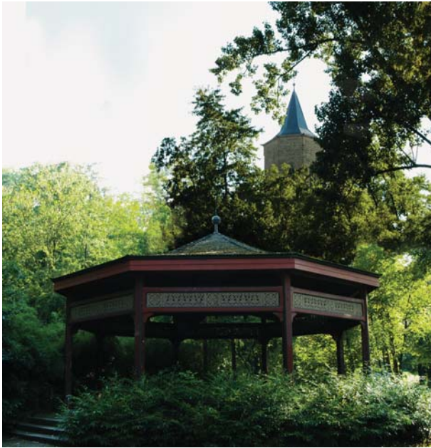
Der Pavillon auf der kleinen Erleninsel, entstanden aus Teilen der Vordächer des historischen Bahnhofsgebäudes
